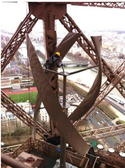
**Ambos aerogeneradores, con 7 m de altura y 3 m de envergadura cada uno, se han instalado a 127 m del suelo, a la altura de la 2.ª planta, porque esta zona es la más adecuada por su óptima exposición al viento.**
