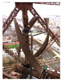
Les deux éoliennes de 7 m de haut sur 3 m d'envergure ont été installées à 127 m au-dessus du sol, au niveau du 2e étage, cet espace étant le plus adéquat pour une prise au vent optimale.
